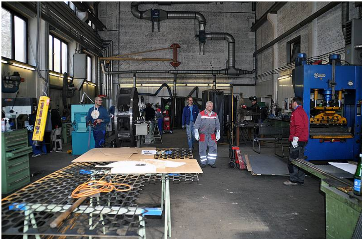
Abb. 10: Werkshalle des Kraftwerks Riedersbach.
